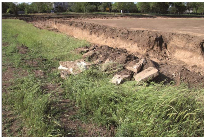
Фото 4. Котлован на месте обнаружения надгробий (г. Старый Крым)
