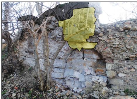
Рис. 4. Ханский дворец. «Восточное строение» предполагаемого Зала Дивана Сахиб Гирея (северная стена). Сейсмогенная деформация плинфовой арки с простирианием  $88^0$ : а) потеря верхней центральной части плинфовой арки; б) ремонт плинфовой арки бутовым камнем; в) следы закладки антисейсмического компенсационного бруса, технология «дувар-кушак»; д) приспособление «восточного» строения в советский период (бетонный армопояс).
