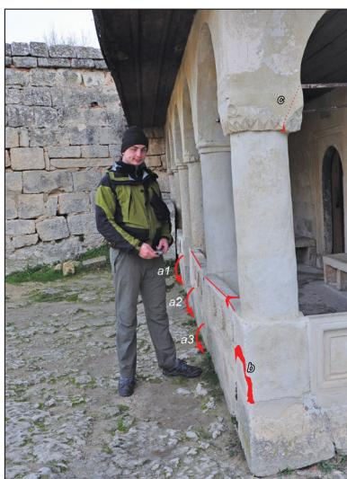
Рис. 9. Крепость Чуфут-Кале. Большая кенасса. Вид на северо-восточную галереи: а – колонны со сталактитовыми эхинами на капителях; б – колонны с эхином в виде округлой подушки и восьмигранной шейкой. Красной заливкой показаны трещины в базах колонн и каменных плитах ограды, образовавшиеся от их вращения против часовой стрелки.
